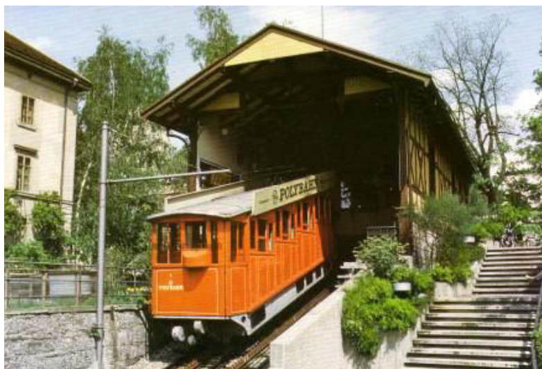
Polybahn, Bergstation, 8001 Zürich
